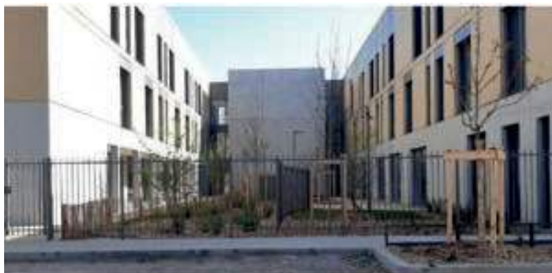
Le bâtiment en H est construit sur 3 niveaux à l'angle Guynemer/Les Étoiles. Photo Monique Desgouttes Rouby
